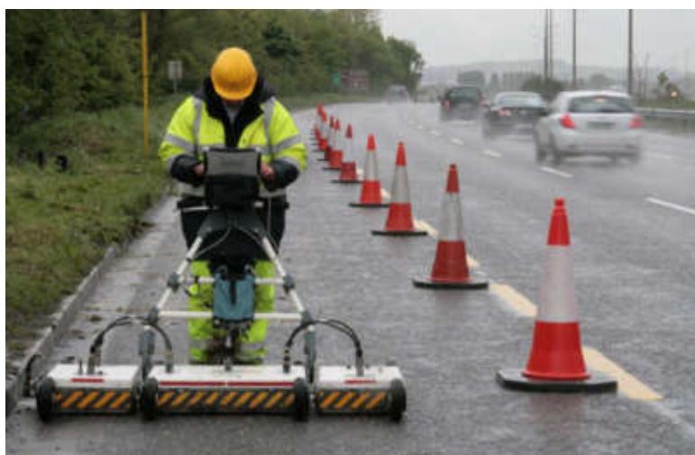
Immagine – Esempio di rilevamento delle reti nel sottosuolo attraverso georadar
