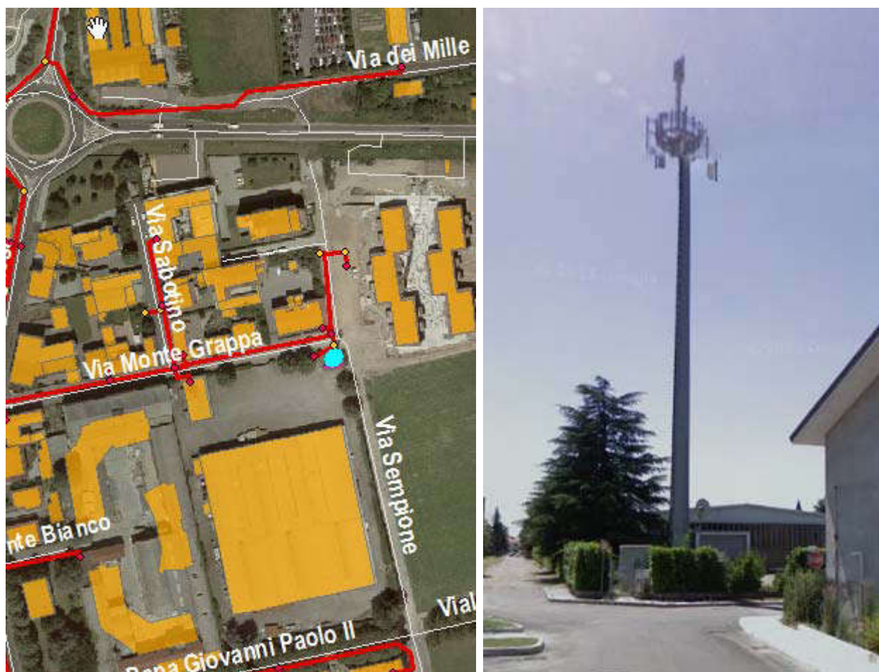
Immagine – Antenna telefonia in via Monte Grappa e sua localizzazione nel Gis.
