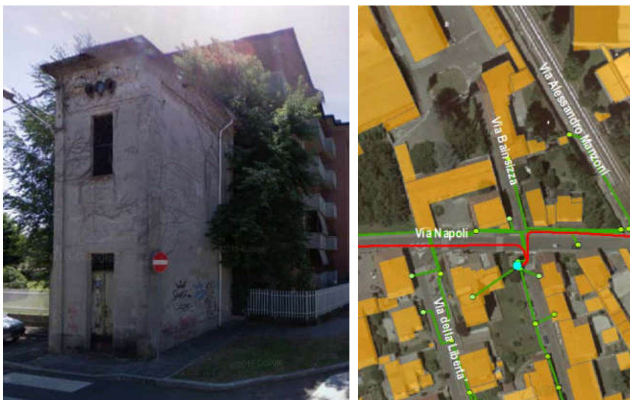
Immagine – Cabina MT in via Napoli e sua localizzazione nel Gis.
