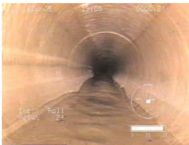
Immagine – Esempio di apparecchiatura per video ispezioni dei condotti fognari
